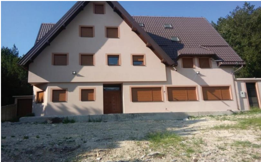
Slika 1. Upravna zgrada JP Park prirode Blidinje
