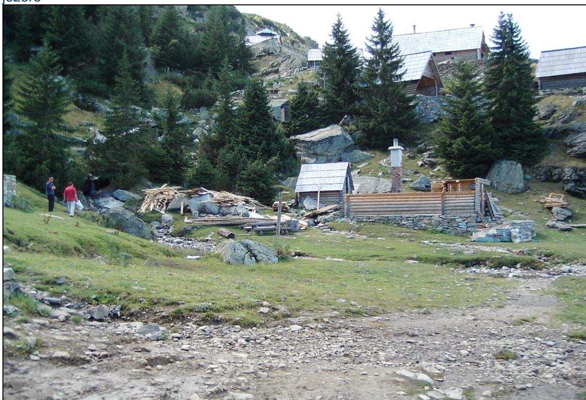
Slika 3.39. Primjer namjernih negativnih antropogenih utjecaja: vikend objekti u fazi izgradnje u neposrednom koritu Razvalinskog potoka
